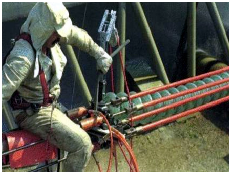
Slika 123: Metoda "na potencijalu" (rad u uvjetima jednakog potencijala)
