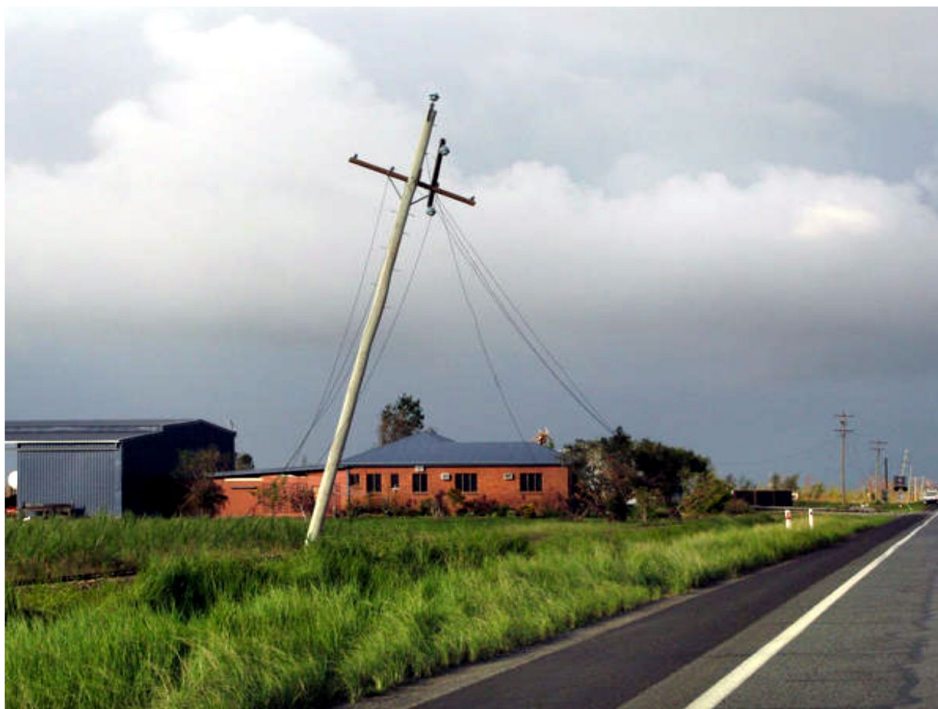
Slika 120: Vodič visokonaponskog voda „srušen“ na zemlju
