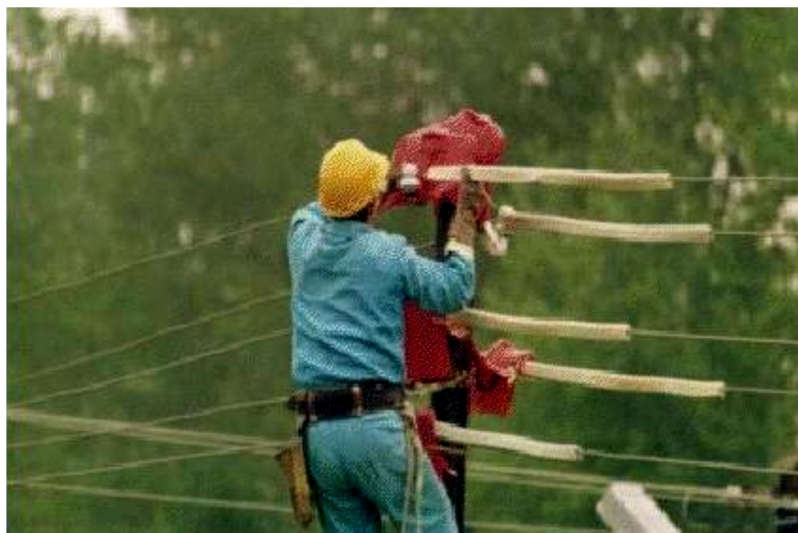
Slika 121: Primjer prekrivanja vodiča pod naponom
