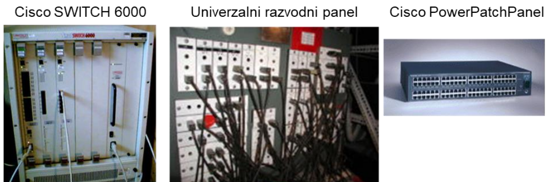
Slika 9.3. Primjeri aktivne i pasivne mrežne opreme
